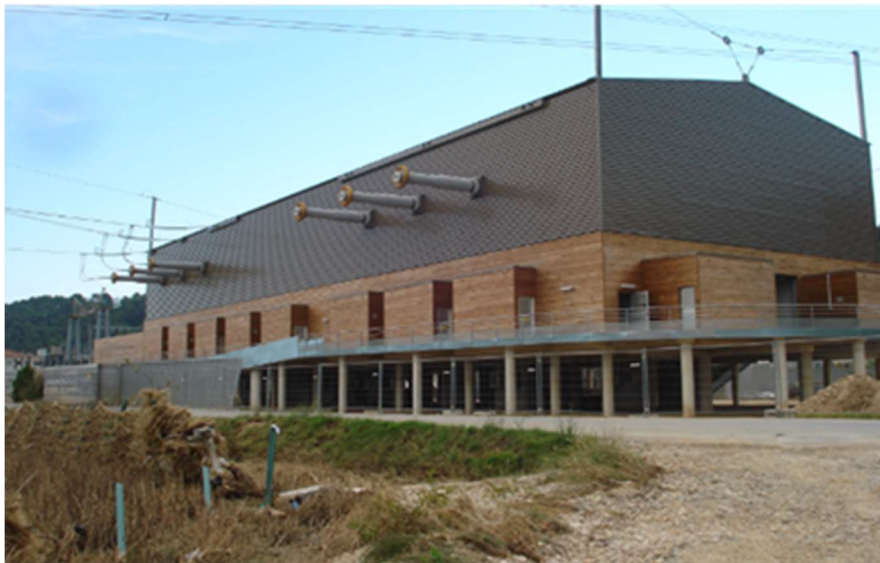
Ilustración 5: ejemplo de construcción sobre pilotes
